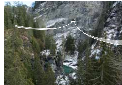
Zwei Brücken-Etappen: 120m und 240m.
