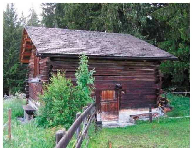
Ansicht Dach mit Holzschindeleindeckung
