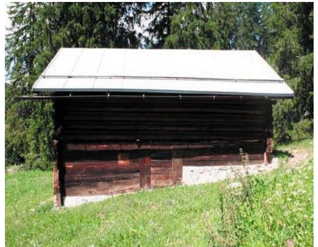
Ansicht Dach mit Blecheindeckung
