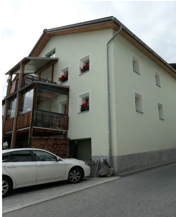
Objekt Nr. 50 / Voia Principala 49 (SSF bereits beim LSP 2002 finanziert)
