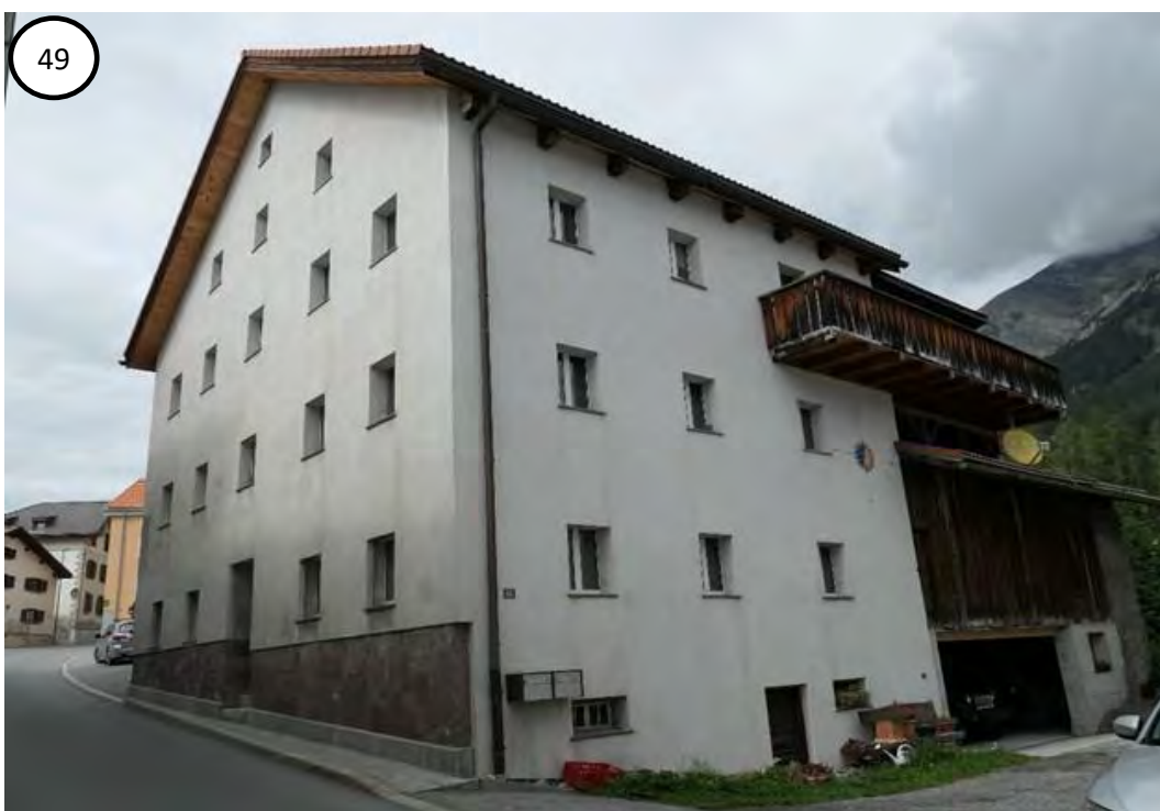
Objekt Nr. 49 / Voia Principala 46 (SSF bereits beim LSP 2002 finanziert)
